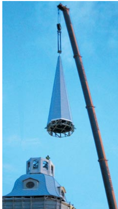
30 июня 2015 г. Подъем воссозданной конструкции купола с 14-метровым шпилем на колокольню собора Благовещения Пресвятой Богородицы в Шлиссельбурге
