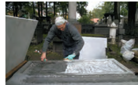
Памятник А. Васильеву в процессе реставрации, расчистка поверхностей надгробных плит на могилах его близких родственников от сажепылевых загрязнений и биопоражений, общий вид семейного захоронения по завершении работ
