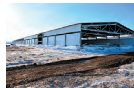
Некоторые примеры строящихся и завершённых строительством зданий с использованием ЛСТК-Элш профиля в качестве элемента базовых конструкций
