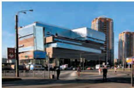
ТРК «Международный» на пересечении улиц Бельи Куна и Бухарестской со встроенным наземным павильоном одноименной станции метро
