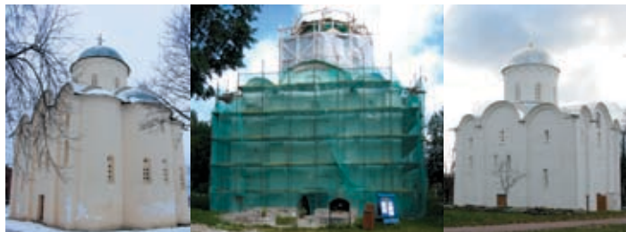
Здание Успенского собора в Старой Ладоге (постройка 1116 г.) до, в процессе и после реставрации
