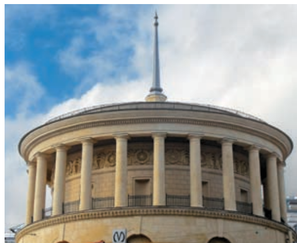
Ротонда павильона станции «Площадь Восстания» после реставрации. Фото ноября 2012 г.
