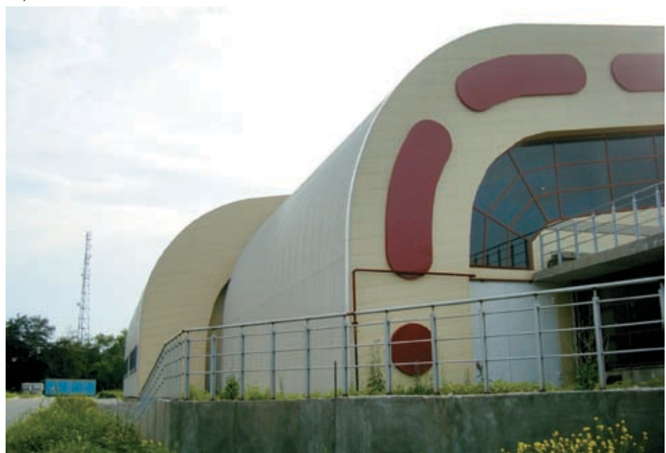
Фрагменты фасада здания торгового комплекса «Гладиатор» в Нальчике на завершающем этапе строительства
